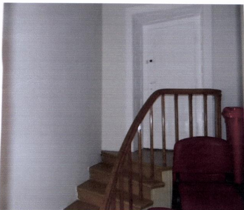
Fot. nr 8. Widok na drzwi czwartego wyjścia na K-1. Wysokość drzwi ok. 1,8 m i szerokość 0,9 m w świetle ościeżnicy
