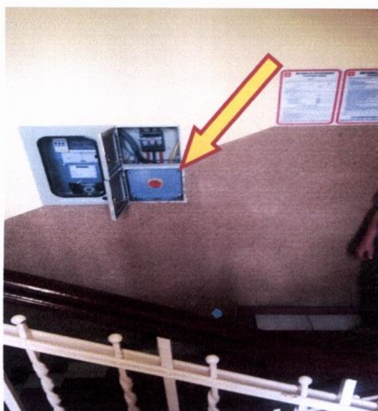
Fot. nr 15. Widok na główny wyłącznik prądu
